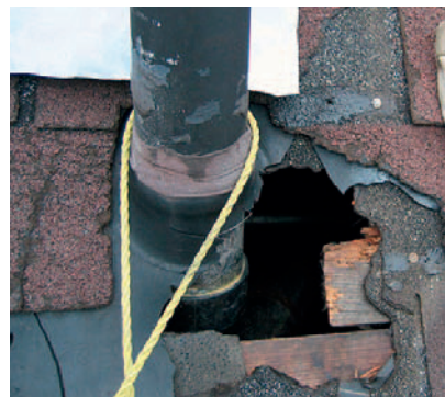
▲ So sehen typische Schäden aus, die ein Marder in einem Dach anrichten kann und die der umgehenden Reparatur bedürfen. Mit seinen spitzen Zähnen kann der Marder erhebliche Schäden verursachen. Neben dem Motorraum von Automobilen gehören die Dachböden zu den beliebtesten Behausungen der Raubtiere.
