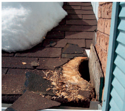
▲ So sehen typische Schäden aus, die ein Marder in einem Dach anrichten kann und die der umgehenden Reparatur bedürfen. Mit seinen spitzen Zähnen kann der Marder erhebliche Schäden verursachen. Neben dem Motorraum von Automobilen gehören die Dachböden zu den beliebtesten Behausungen der Raubtiere.
